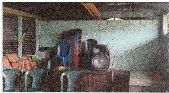
FOTO 6: Pintura en muros exteriores e interiores
