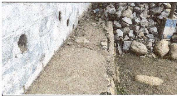
FOTO 5: Reparación de banquetas de concreto
