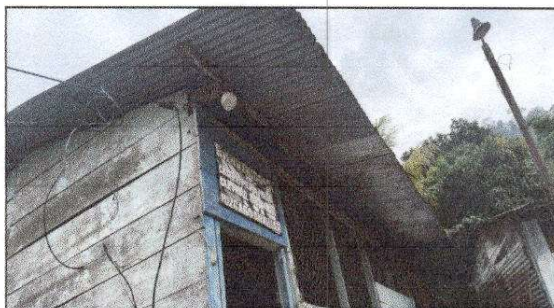
FOTO 4: Sustrucción de canal de metal, Sustrucción de bajada de agua pluvial de metal por tubo PVC 3", Sustrucción de soporte o pescante de metal para canal.
