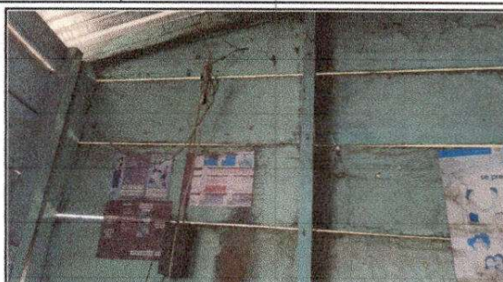
FOTO 8: Instalación de unidades luz (incluye interruptor, ducto y cable eléctrico)
