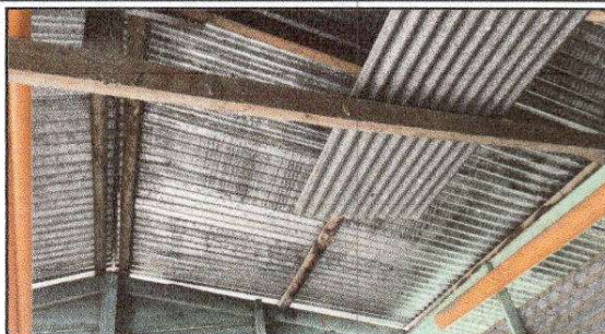
FOTO 2: Sustrucción de estructura de soporte de madera, por metal, Instalación de estructura portante de metal, Desinstalación de estructura portante.
