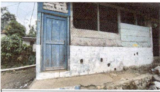
FOTO 11: Fabricación e instalación de puertas de metal en módulos
