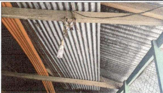
FOTO 7: Sustitución de focos ahorradores
