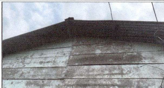
FOTO 1: Sustrucción de lámina, por lámina troquelada aluzinc calibre 26, Sustrucción de capote de lámina para lámina troquelada, Sustrucción de elementos de fijación, Instalación de lámina troquelada aluzinc.
