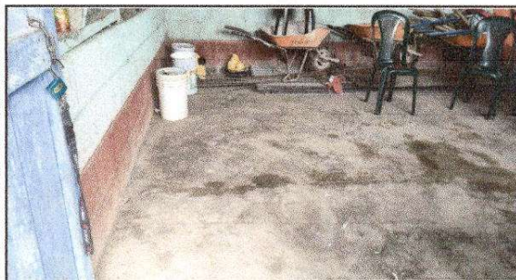
FOTO 3: Sustrucción de piso cerámico
