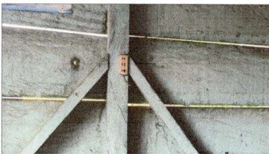
FOTO 9: Instalación de unidades fuerza (tomacorriente), incluye cable eléctrico
